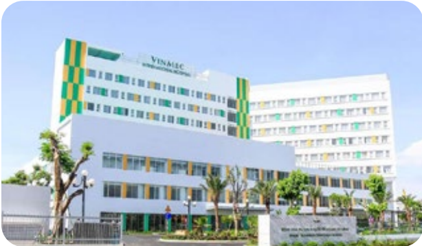
Bảo dưỡng hệ thống bình nóng lạnh tại Bệnh viện Vinmec Đà Nẵng
