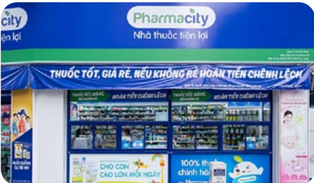
Bảo dưỡng hệ thống điều hòa cho chuỗi cửa hàng Pharmacy
