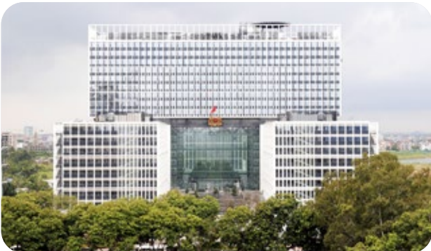
Bảo trì hệ thống cấp quang của Bộ Công an
