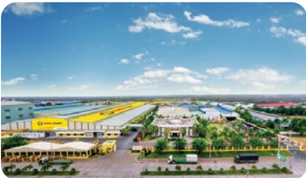
Vệ sinh, bảo dưỡng hệ thống điều hòa công nghiệp tại Công Ty TNHH TMDV CN Thuận Thịnh Phát
