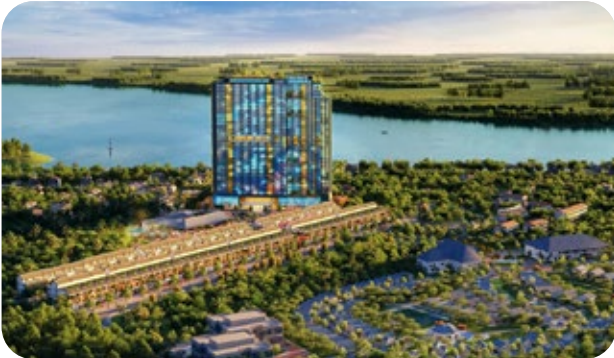
Thi công lắp đặt hệ thống điện lạnh cho khu nghỉ dưỡng Wyndham Thanh Thủy
