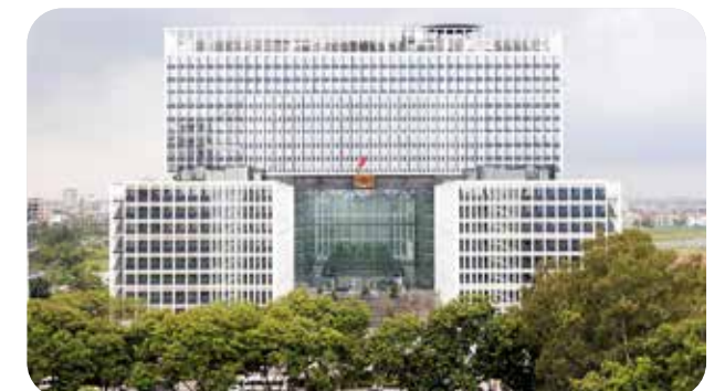
Bảo trì hệ thống cấp quang của Bộ Công an
