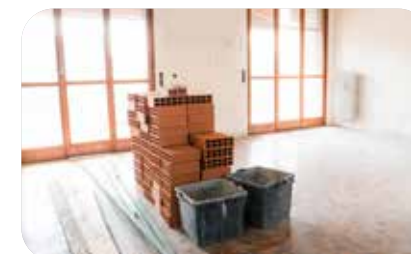
4. CẢI TẠO, SỬA CHỮA DÂN DỤNG
