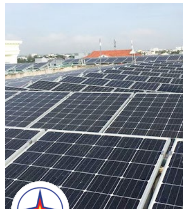
Thi công hệ thống điện NLMT cho điện lực Bạc Liêu (2.1 MWP)
