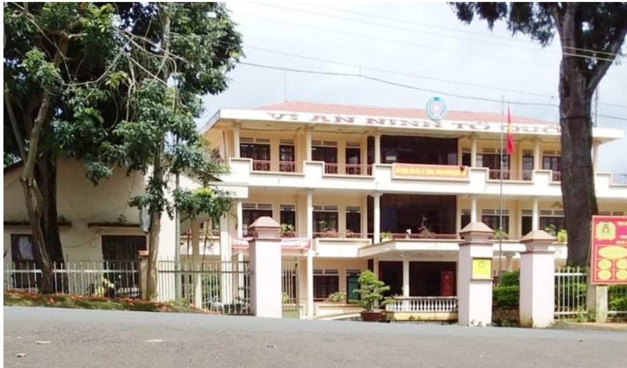
XÂY DỰNG CƠ SỞ LÀM VIỆC CHO LỰC LƯỢNG CÔNG AN XÃ (26 XÃ GIAI ĐOẠN 3)
