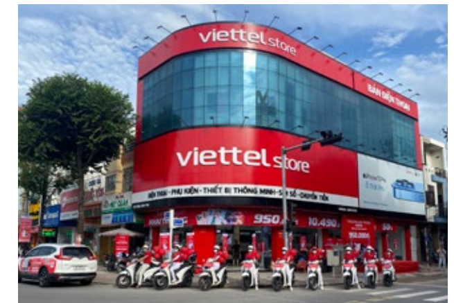
Chuỗi Viettel Store: Bảo trì bảo dưỡng điều hòa tại các cửa hàng, siêu thị Viettel Store trên toàn quốc
