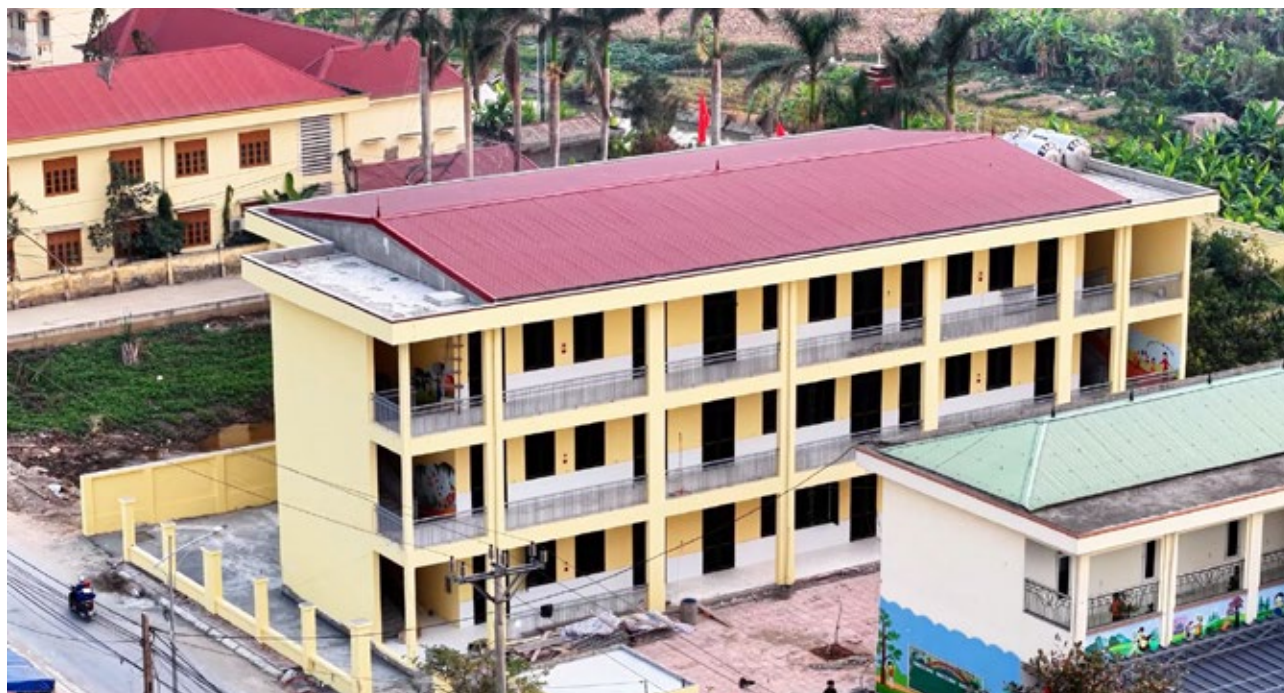
ĐẦU TƯ XÂY DỰNG CƠ SỞ HẠ TẦNG NÔNG THÔN MỚI KIỂU MẪU XÃ TỰ CƯỜNG Địa điểm dự án: Hải Phòng Chủ đầu tư: Ban QLDA đầu tư xây dựng huyện Tiên Lãng
