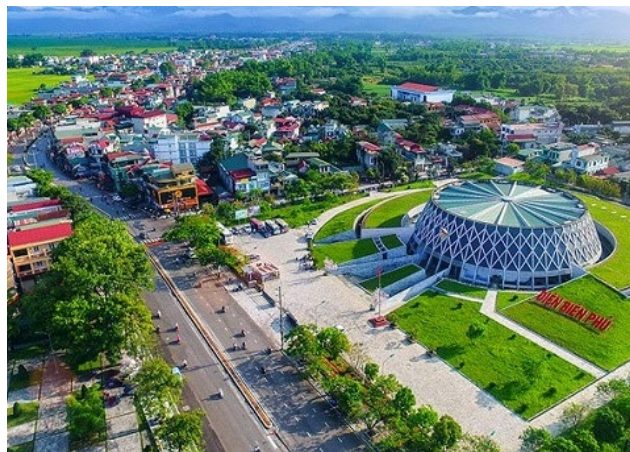
Cung cấp, lắp đặt thiết bị, phần mềm và kênh truyền - Xây dựng nền tảng công nghệ thành phố thông minh tỉnh Điện Biên
