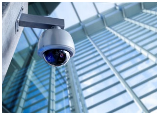
Cung cấp dịch vụ lắp đặt hệ thống camera giám sát - Công Ty CP Thiết Bị Và Phát Triển Công Nghệ Trọng Điểm
