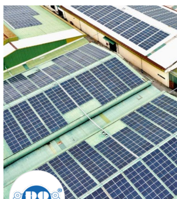
Thi công hệ thống điện NLMT Công ty CP Dệt Đông Quang (40 MWP)
