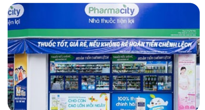
Bảo dưỡng hệ thống điều hòa cho chuỗi cửa hàng Pharmacy
