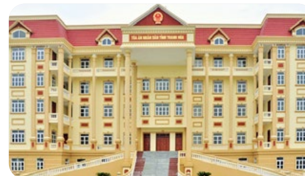
Lắp đặt hơn 2500 điều hòa cho Trụ sở Tòa án Nhân dân tại 63 tỉnh
