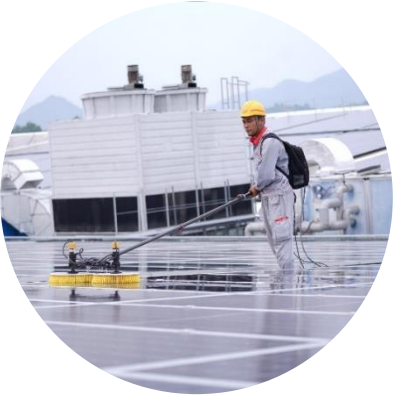
Lắp đặt, bảo trì hệ điện NLMT
