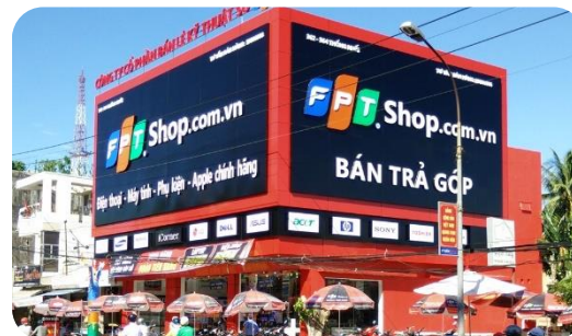
Bảo dưỡng hệ thống điều hòa cho chuỗi cửa hàng FPT Shop
