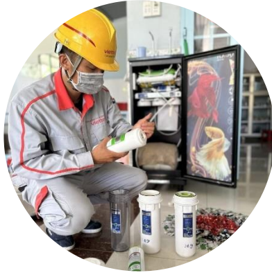
Thay thế lõi lọc nước
