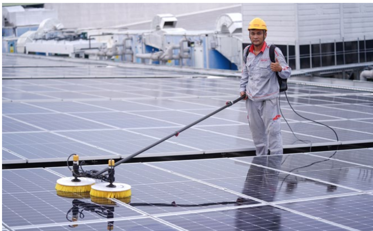
BẢO DƯỠNG HỆ THỐNG NLMT GREENYELLOW (900KWP TẠI HÀ NỘI)
