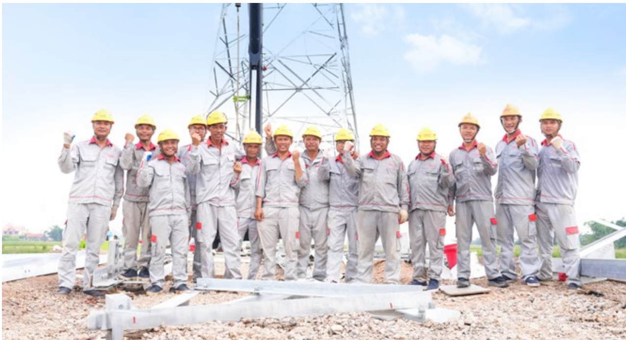
THI CÔNG MÓNG & BỜ KÈ, LẮP DỰNG CỘT MẠCH 3 Địa điểm dự án: Nam Định, Thái Bình, Thanh Hóa, Hà Tĩnh Chủ đầu tư: Tập đoàn EVN
