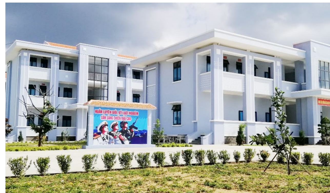
NHÀ Ở CHIẾN SỸ LỮ ĐOÀN 83 – QCHQ ĐÀ NẴNG Địa điểm dự án: Đà Nẵng Chủ đầu tư: Quân chủng Hải quân Đà Nẵng
