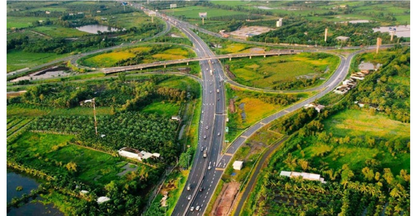
CÔNG TRÌNH NÚT GIAO CÁI BÈ TIỀN GIANG Địa điểm dự án: Tiền Giang Chủ đầu tư: Bộ Giao thông vận tải
