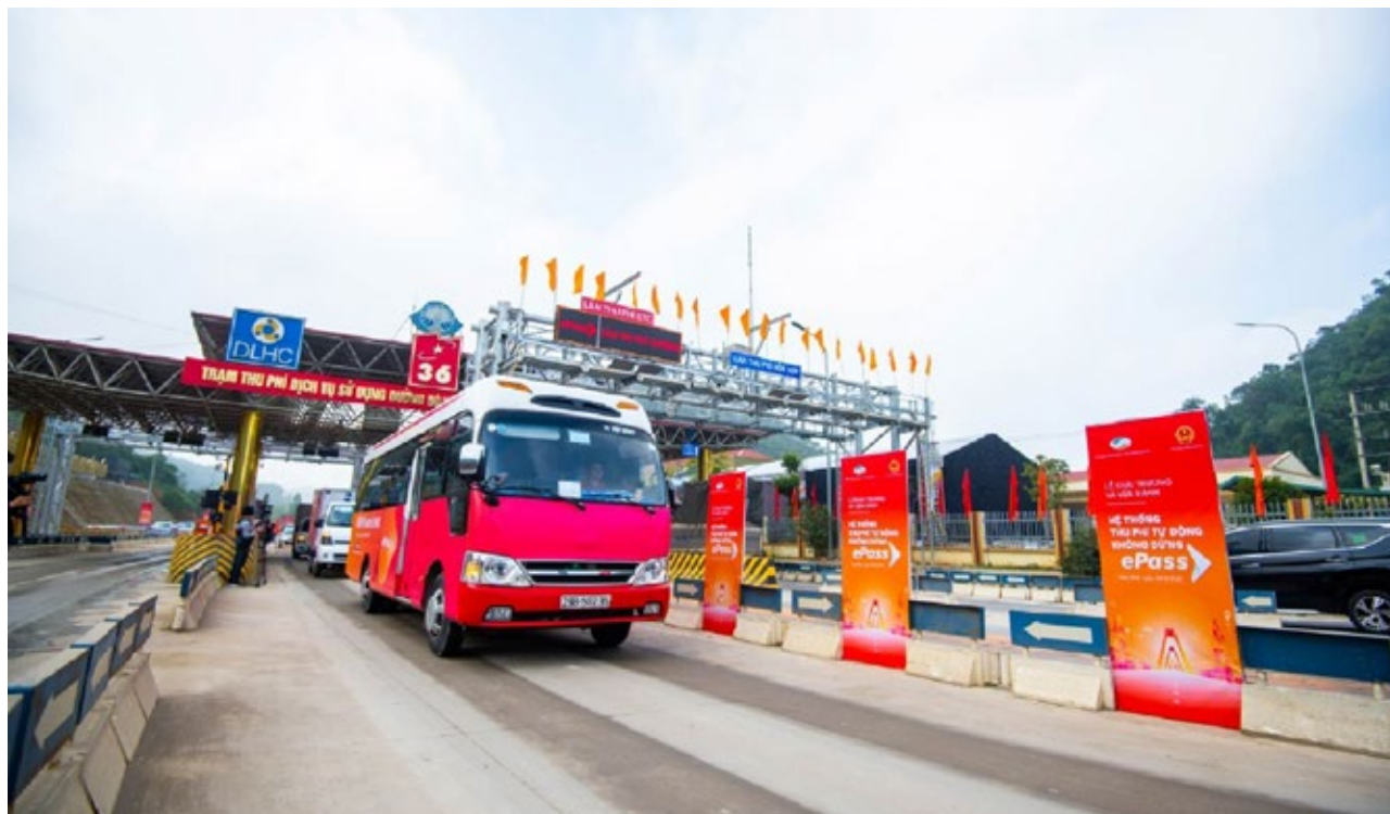
TRẠM THU PHÍ KHÔNG DỪNG EPASS Địa điểm dự án: Toàn quốc Chủ đầu tư: Bộ Giao thông vận tải
